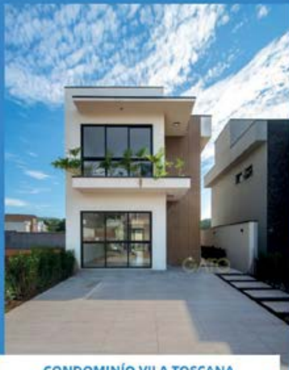
CONDOMÍNIO VILA TOSCANA
